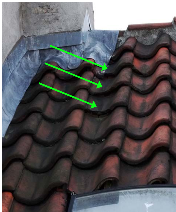
Slangerupgade 28 ved brandkam. Flere beskadigede sten.
