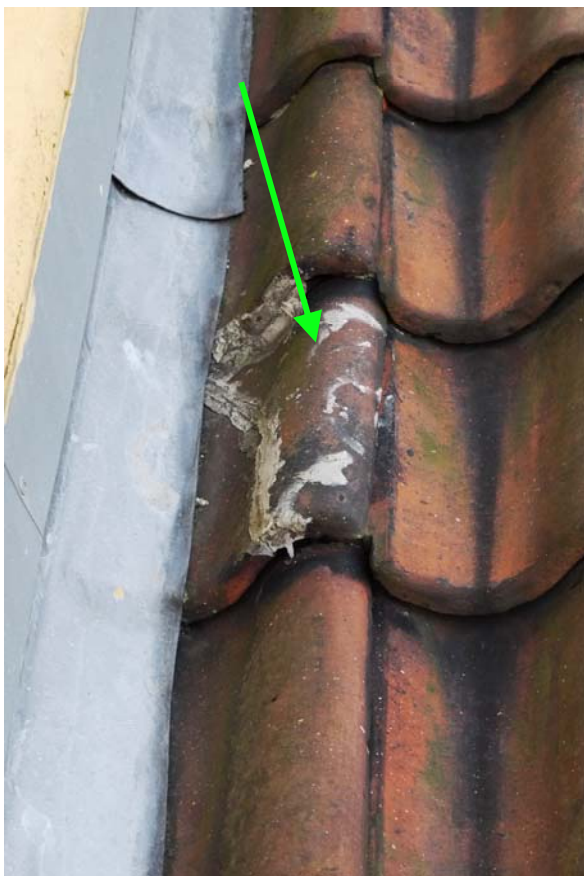
Slangerupgade 24 ved trappetårn (mod nr. 26) revnet sten skiftes
