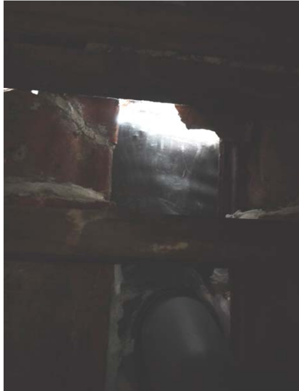
Åbent tag ved faldstamme gennemføring ved Slingerupgade 24 og 20
