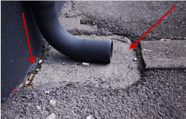
Bundpladen ved nedløbsrør på gadesiden ligger for lavt. Der er revne mellem asfalt og sokkel, gadesiden
