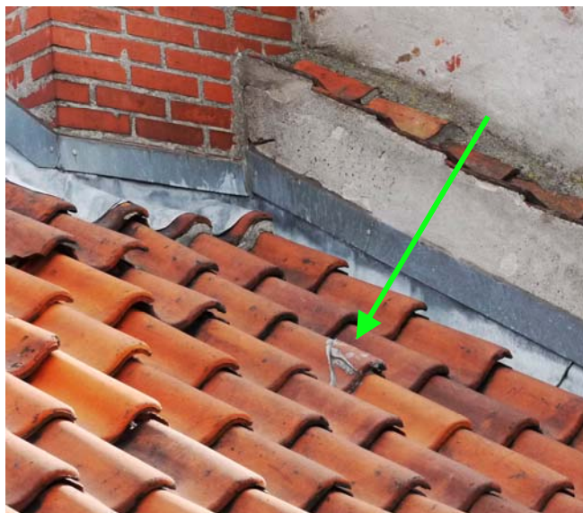
Mellem Valkyriegade 17-nabobygning. Revnet tagsten skiftes
