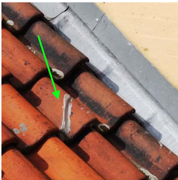
Ved trappetårn Slangerupgade 18. Revnet tagsten skiftes
