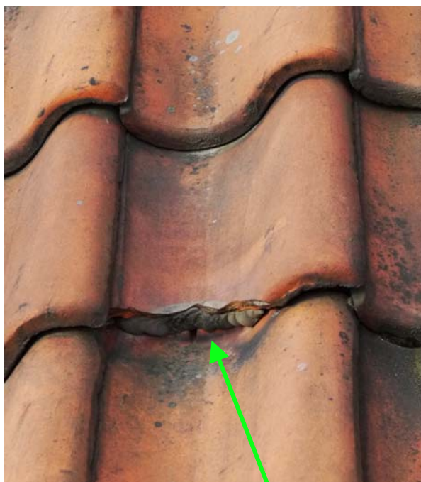
Mellem Valkyriegade 23-25 gadeside, tagsten repareret med silikone
