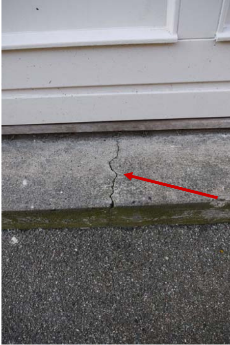
Revnet dørtrin, bagtrappe Slangerupgade 24 og Valkyriegade 25
