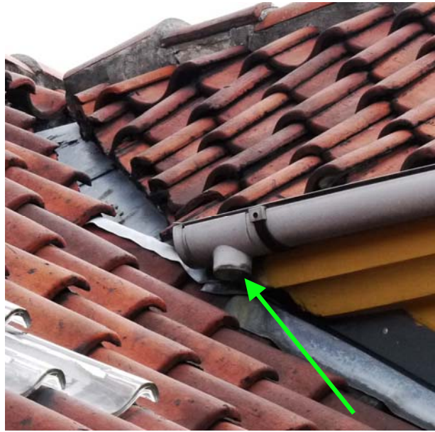
Nedløb der mangler på trappetårn, Valkyriegade 27
