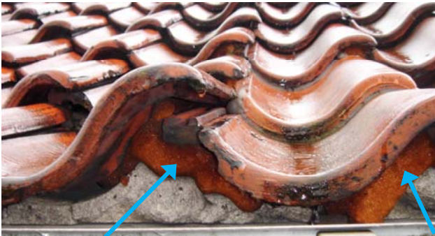
Taget mod Aldersrogade ligger ujævnt da der er brugt fugeskum som understrygning.
