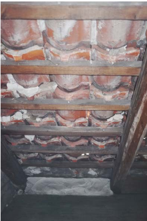
Vingetegl mangler understrygning flere steder. (foto fra loftsrum 84)
