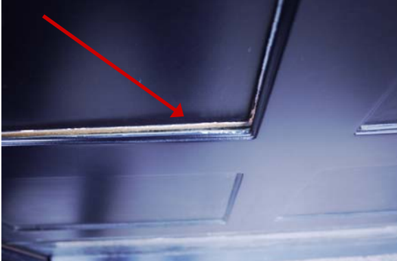
Beskadiget dør fyldning
