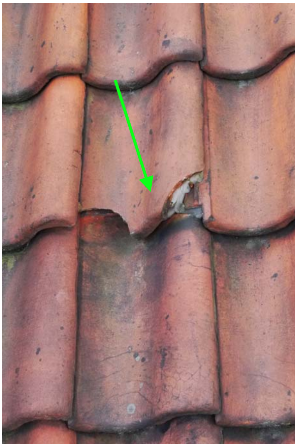
Mellem Slangerupgade 18-nabobygning. Revnet tagsten skiftes
