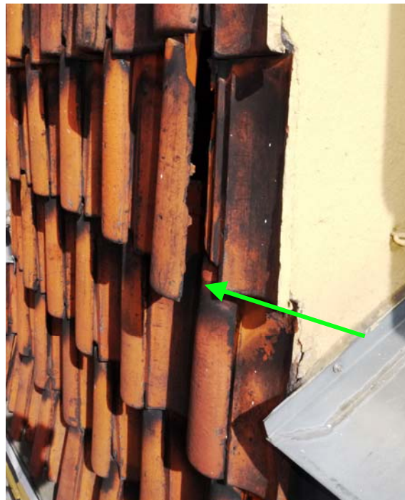
Mellem Valkyriegade 17-19. Løs tagsten på mansarden. Risiko for nedstyrtning. Fastgøres indenfor 3 mdr.
