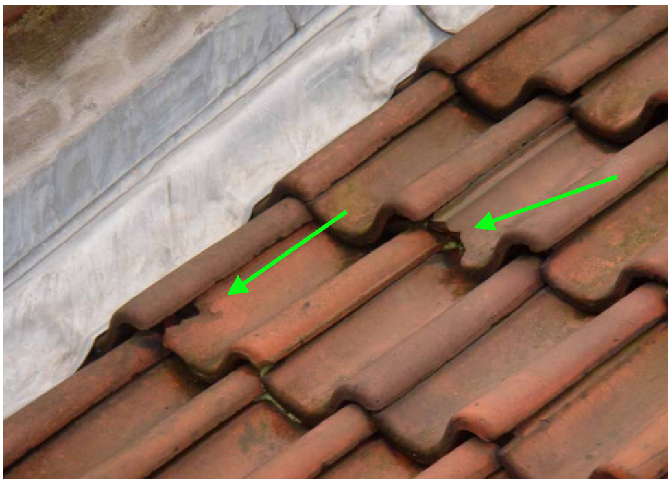
Ved Valkyriengade 17, ved tagindækning
