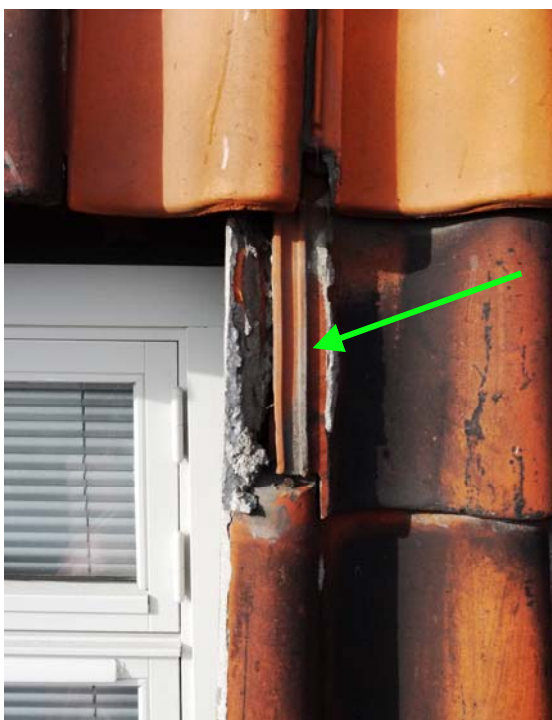
Mellem Valkyriegade 17-19 gadeside, tagsten på mansard Taget bør opsættes indenfor 1år
