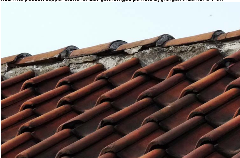
Tagrygning med løs puds på Valkyriegade 24, gadeside
