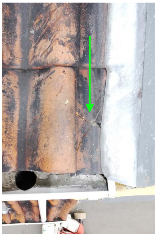
Valkyriegade 23, ved trappetårn. Revnet sten skiftes indenfor 3 mdr.
