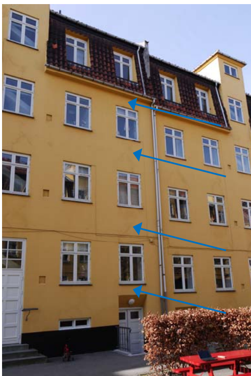
Sætningsrevne ml. Slangstrupgade 26 og 28
