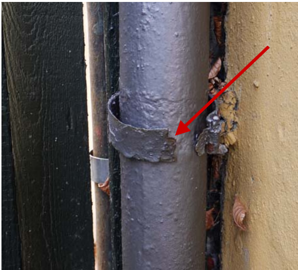
Nedløbsrør gårdside ved naboskel, Slangerupgade 18, Murhagen skal skiftes.
