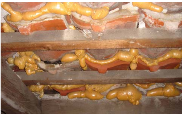
Fugeskum set indefra tagrummet.
