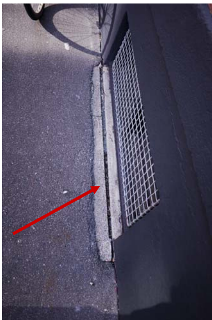
Valkyriegade ml. 27-29. Gl. beton sålbænke bør hugges op og lukkes med asfalt hvor vinduets bundstykke er over terræn
