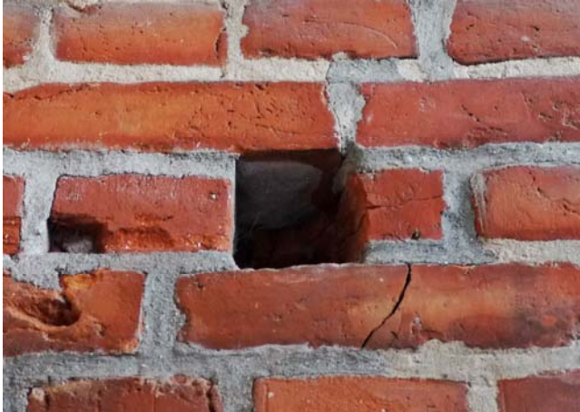
I portrummet, på væggen er der 2 mursten der bør skiftes
