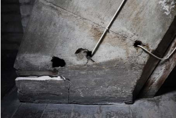
ventilationskanaler på loftet der er hullede
