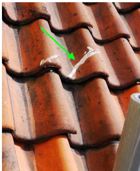
Mellem Valkyriegade 17-nabobygning. Revnet tagsten skiftes
