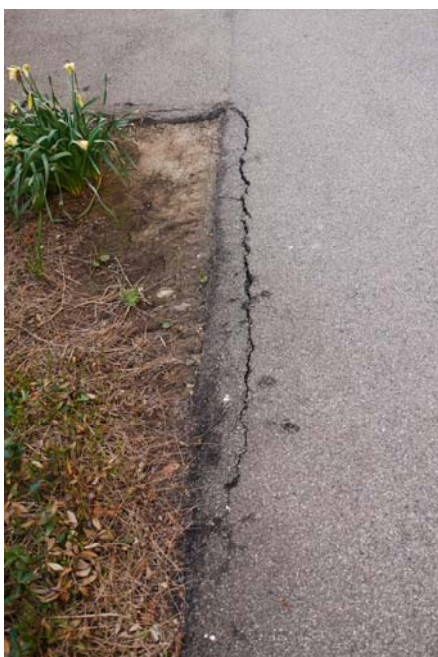
Beskadiget asfalt kanter
