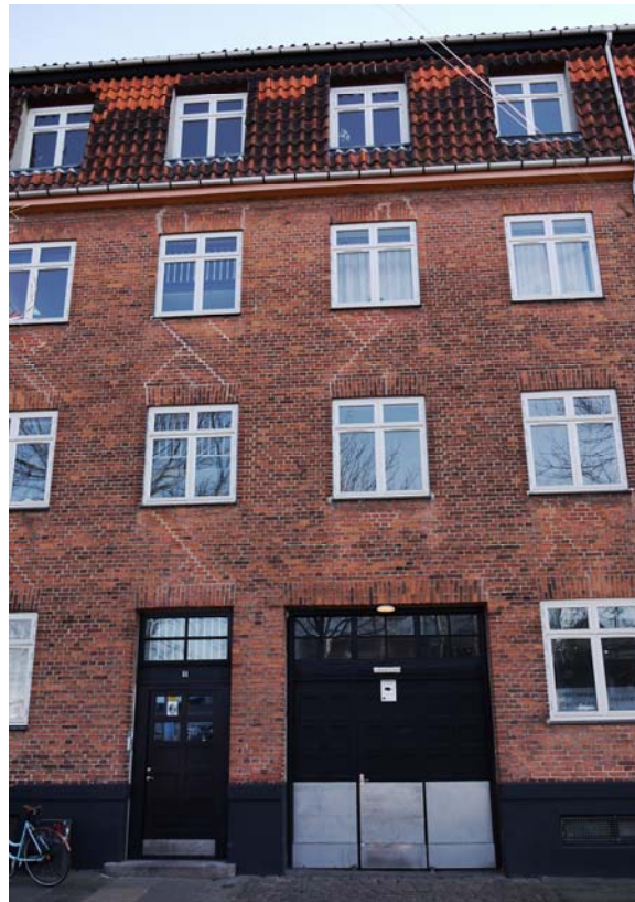
Aldersrogade facade, mange gl. sætningsrevner
