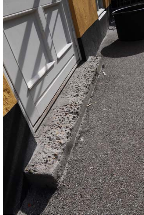
Bagtrappetrin Valkyriegade 17/19/21/23 er slidt og tæret
