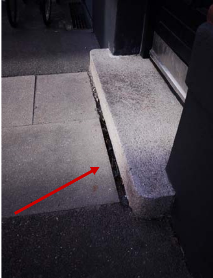
Valkyriegade mellemrum mellem fliser og trædesten
