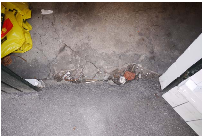
Barnevognsskur, revner i gulv ved indgang
