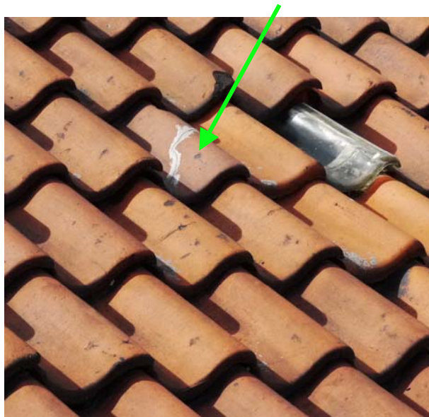
Mellem Slangstrupgade 30-32. revnet sten skiftes
