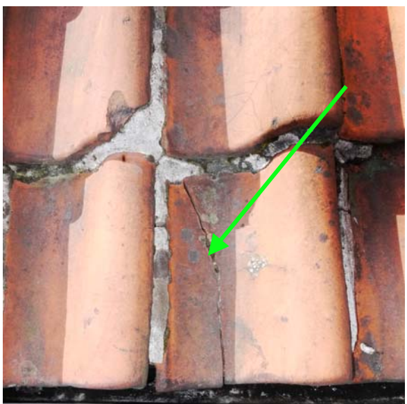
Mellem Slangerupgade 18-20. revnet sten skiftes indenfor 3 mdr.
