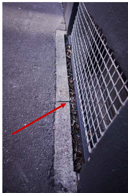
Valkyriegade ml. 27-29. Hvor vinduets bundstykke er under terræn hugges op og støbes en lyskasse
