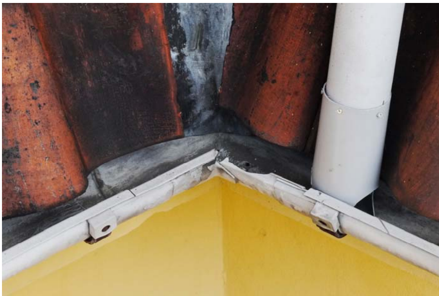
Beskadiget tagrende på gårdside, hjørnet af Aldersrogade og Valkyriegade 3år
