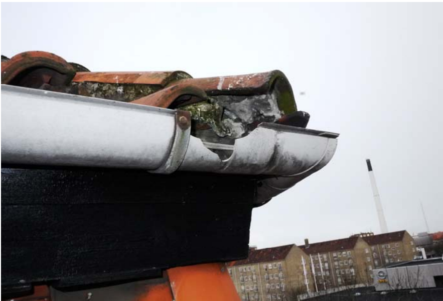
Beskadiget tagrende på gadeside, hjørnet af Aldersrogade og Valkyriegade
