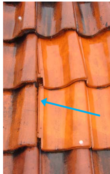
Hvor det er skiftet sten er der brugt vindetegl der er en smule mindre end de originale tagsten, revnen er ofte tætnet med fugeskum.
