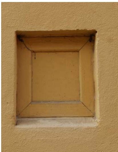
Krydsfinerplader i svalesskabs vinduer bør fjernes og lukkes med uorganisk materiale
