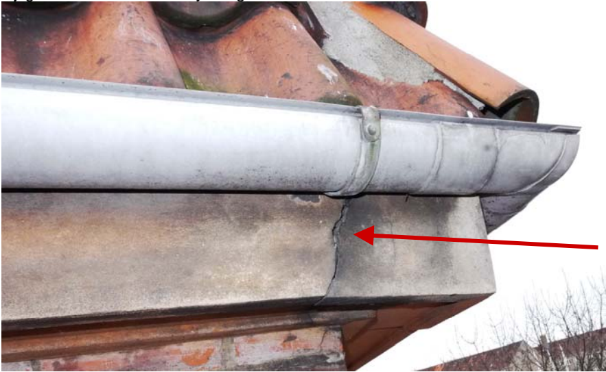
Revnet murkrone på hjørnet af Aldersrogade og Valkyriegade
