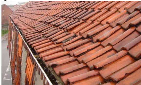
Taget mod Aldersrogade ligger ujævnt da der er brugt fugeskum som understrygning.
