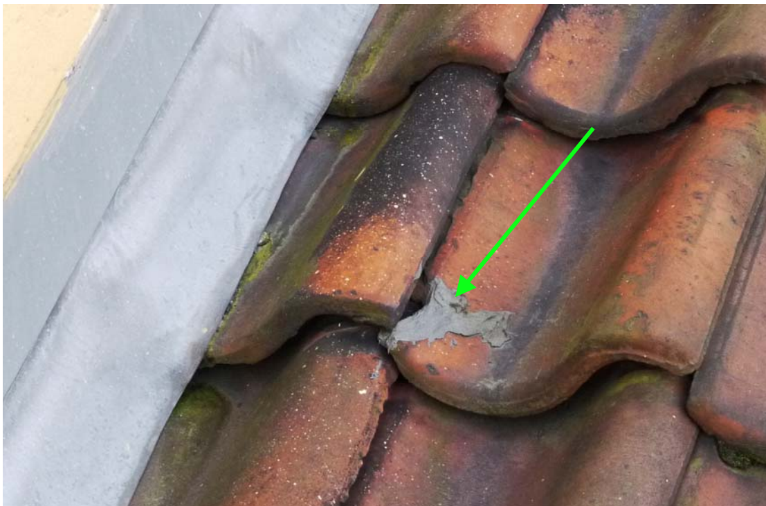
Mellem Slangerupgade 20-22. revnet sten skiftes
