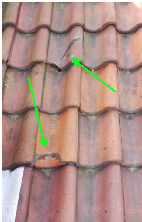
Mellem Slangerupgade 20-22. revnet sten skiftes
