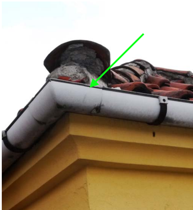
Nederste rygningsten på trappetårn, Valkyriegade 19 er løs og blev nedtaget under eftersynet. Stenen står i kælderen Valkyriegade 19. Opsættes indenfor 3 mdr.
