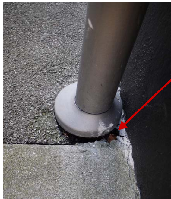
Nedløbsrør ml. Slangerupgade 24-26 og Aldersrogade 49-51 gård, der bør lukkes med asfalt omkring nedløbsrøret
