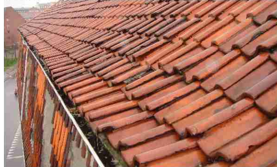
Taget mod Aldersrogade ligger ujævnt da der er brugt fugeskum som understrygning. Nederste 2 rækker tagsten bør omligges hvis der er muligt for en fornuftig pris.
